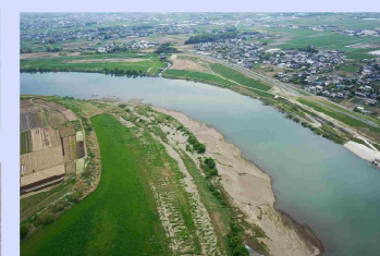
俯瞰（斜め）写真の撮影
